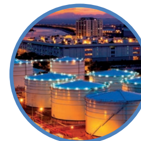
ALMACENAMIENTO DE GAS
